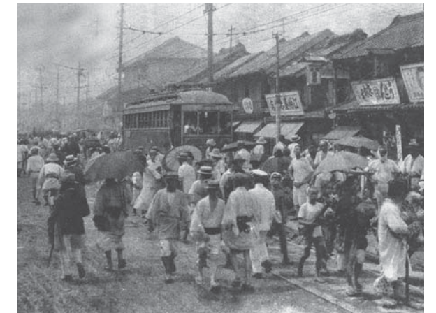
在余震和火中混乱不堪的东京市本所区石原町附近（朝日新闻社提供）
