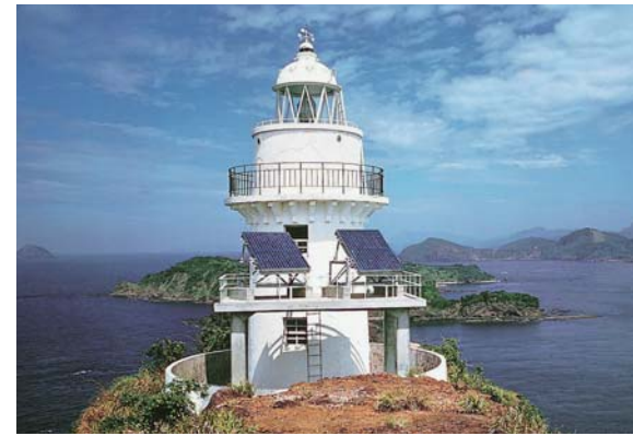
安装太阳能电池的御神岛（现在的尾上岛）灯塔（海上保安厅提供）
