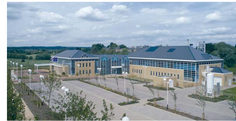
随着1992年新公司厂房竣工，SLE正式开展业务
