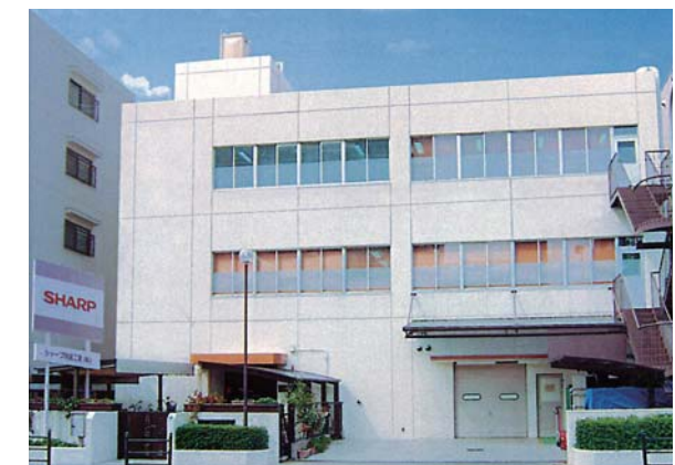
在地方支持下竣工的合资公司早川特选金属工厂新厂房(新工厂)
