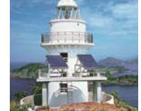
装有当时世界最大输出功率225W太阳能电池的御神岛灯塔（照片提供：海上保安厅）
