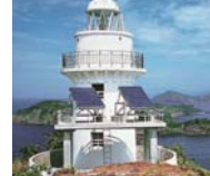
装有当时世界最大输出功率225W太阳能电池的御神岛灯塔(照片提供:海上保安厅)
